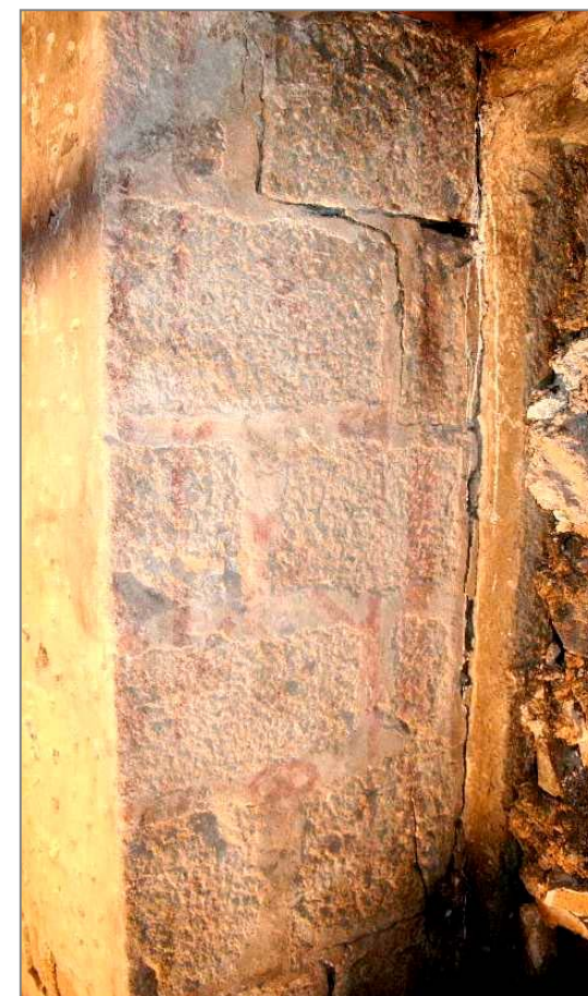
Dues vistes parcials dels muntants descoberts de la finestra núm.3. Podem observar en ambdós casos com el revestiment del mur finalitza just a l'aresta del muntant; a partir d'aquí i a tot l'interior, la pintura s'aplica directament sobre la pedra i l'encintat dels junts. També podem distingir el treball d'acabat dels carreus típicament medieval
