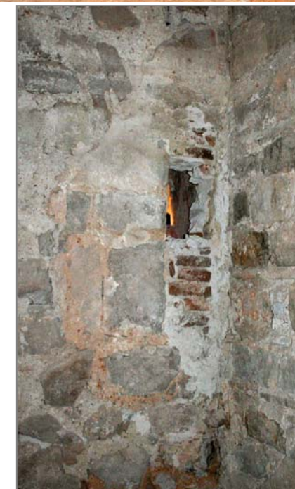
Dues imatges de detall de l'obertura núm. 4. La superior mostra la finestra previament al desmuntatge del seu cegat. La imatge inferior ens mostra el procés d'extracció del conjunt de maons (4 cm. de secció) que tancaven l'obertura pel seu costat extern; el que donava al carrer.
