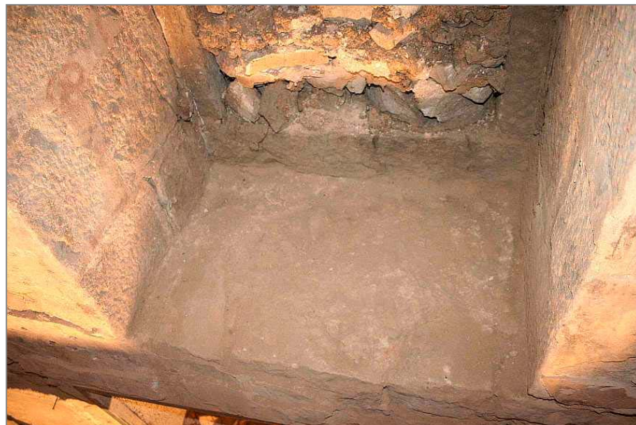
Detall de l'ampit de l'obertura núm.3. Podem observar la manca de revestiment en aquesta zona. També es pot distingir la fondària d'uns 45 cm. de la finestra fins a tocar de l'ampit monolític que s'obra a l'exterior
