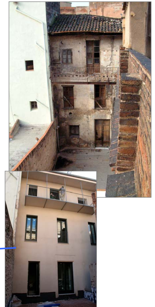
Dues imatges corresponents a la façana del segle XVII que se sosté sobre l'arc que enllaça les torres 28 i 29. La imatge superior és de l'any 2005. La inferior, és d'enguany 2012
