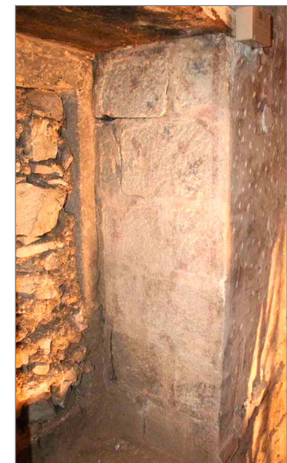
Dues vistes parcials dels muntants descoberts de la finestra núm.3. Podem observar en ambdós casos com el revestiment del mur finalitza just a l'aresta del muntant; a partir d'aquí i a tot l'interior, la pintura s'aplica directament sobre la pedra i l'encintat dels junts. També podem distingir el treball d'acabat dels carreus típicament medieval
