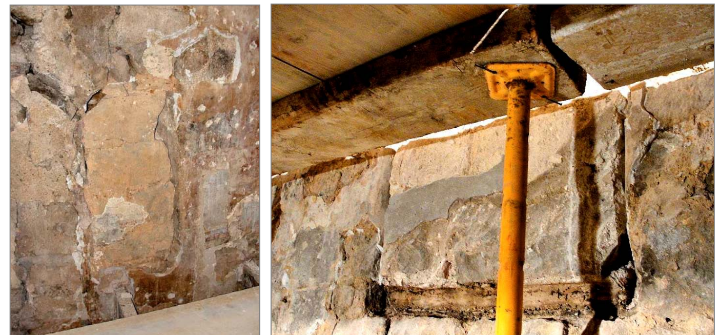
Dues imatges de detall d'algunes de les obertures de la torre. A l'esquerra una finestra localitzada a la paret sud/est. A banda del seu cegat i de com el revestiment es perllonga pels muntants, destaquem la entrega d'un dels caps de biga de l'altell, fet que de manera indirecta ens permet relacionar cronològicament ambdós elements; tema que tractarem més endavant. A la dreta imatge d'una de les finestres del costat més oriental treialtzad desde el ras de la planta baixa. Ambdues imatges són de l'any 2010
