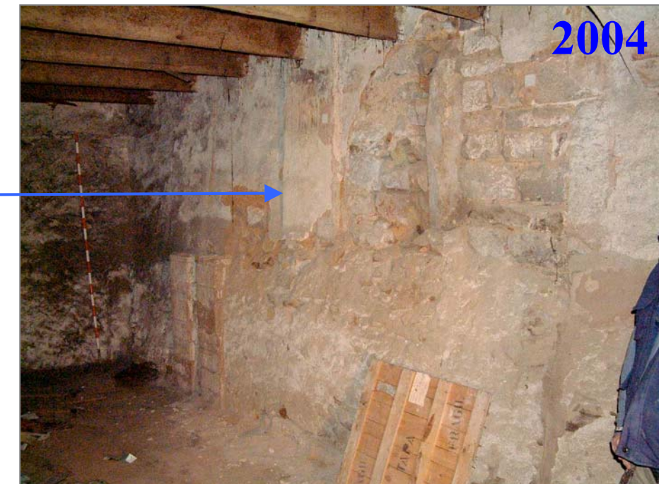
Vista parcial de l'estat del costat més meridional de la planta baixa de la torre núm. 28 l'any 2004
