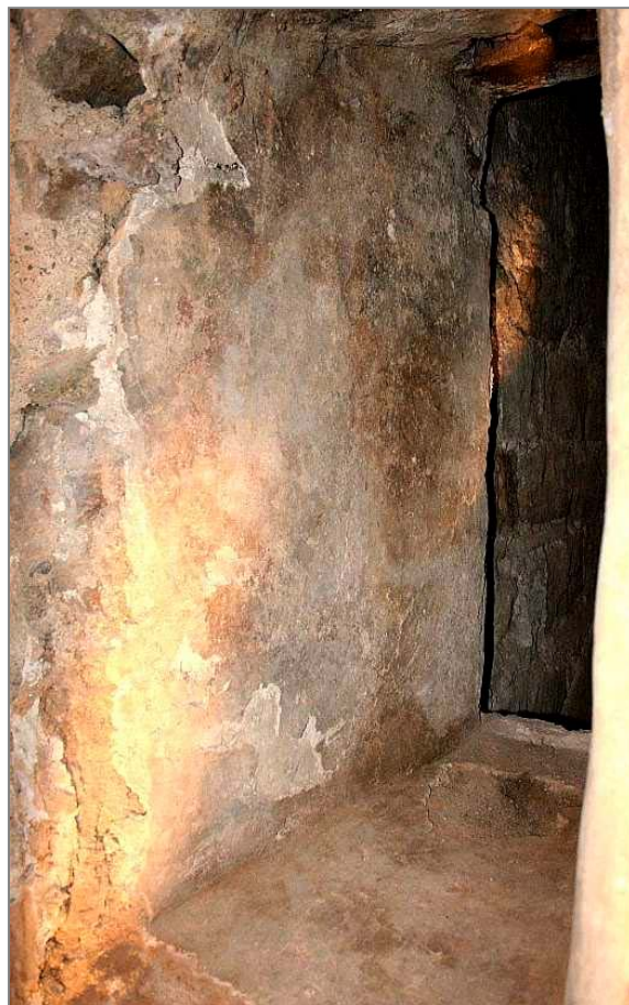
Tres detalls de l'obertura núm.4 un cop retirat el tapiat que la cegava. Les imatges ens donen una visió clara tant de la solució escaixada de l'espitllera com de la forma lleugerament còncaua de la seva llinda
