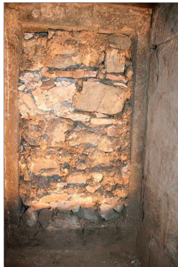
Vista parcial de l'obertura núm. 3 netejada del farciment que la cegava. Podem distingir l'emmarcament petri del costat extern de la finestra, així com el seu rebliment amb pedruscall, trossos de maó massís
