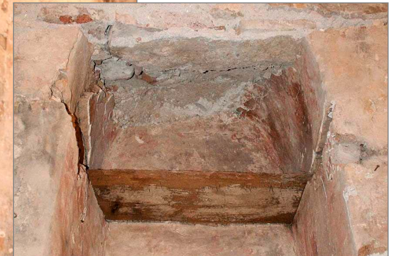
Detall del coronament de la fornícula. Es pot distingir el prestatge de fusta original i el retall de la volta produït per la construcció de l'ampit de la finestra superior.
