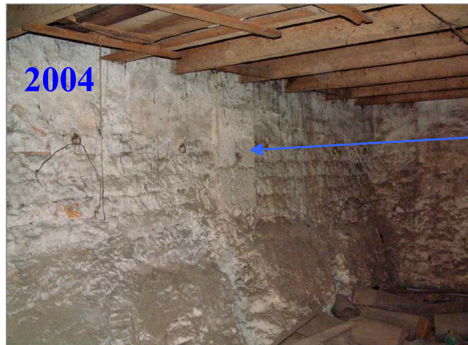
Vista parcial de l'estat del ras de planta baixa de la torre en el seu costat més septentrional l'any 2004. Podem distingir les bigues de fusta de l'altell que dividia l'alçat en dos nivells
