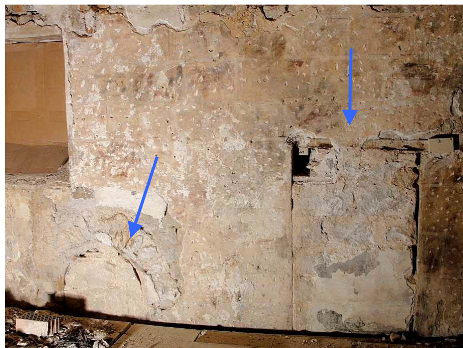
Vista parcial del frontis més oriental de la torre del des nivel de l'altell. S'indiquen les obertures on s'intuïa que el revestiment continuava pel seus brancals (2010).
