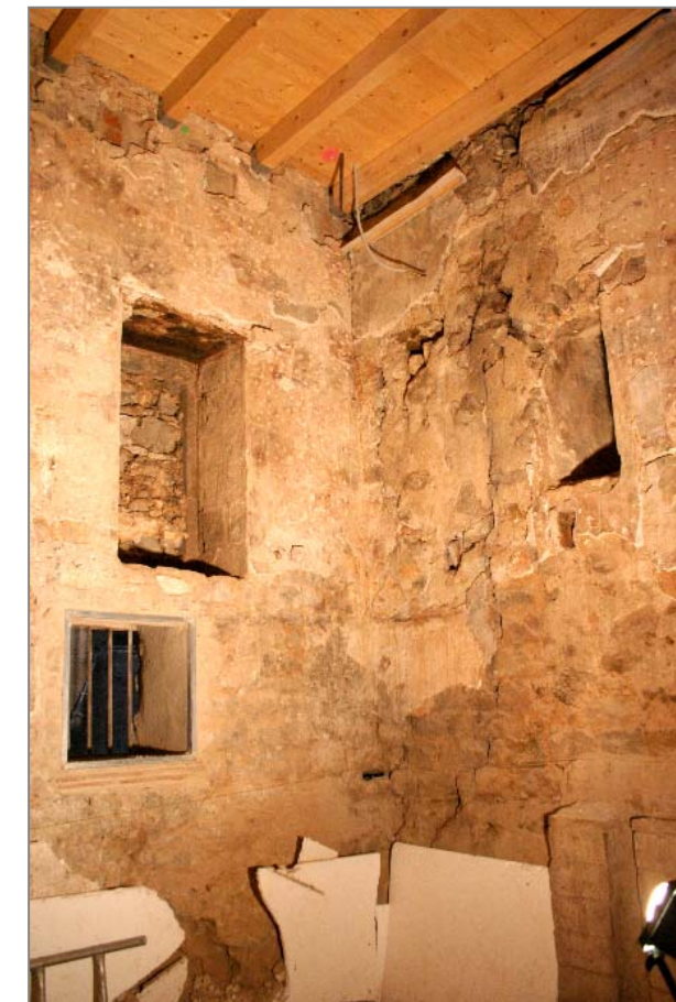
Vista de l'angle sud-est de la planta baixa de la torre 28 un cop finalitzat els desmuntatges dels tapiats. Podem distingir a l'esquerra l'obertura núm. 3 i a la dreta de la imatge l'obertura núm. 4
