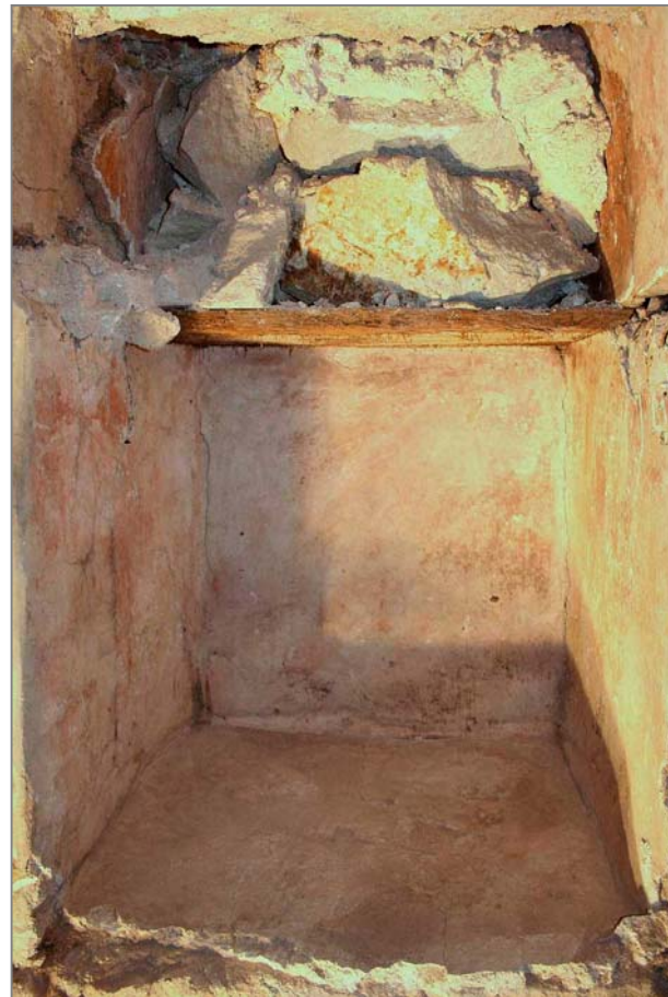
Detall de l'obertura núm.1 en el decurs del procés de desmuntatge del farciment interior del seu cegat. Podem observar com el prestatge fusta original fou emprat com a suport del materials
